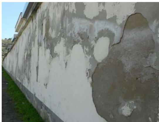
*prima dell'intervento -piano calpestabile in cemento rustico disconnesso, Intonaci muri perimetrali ammalorati*
